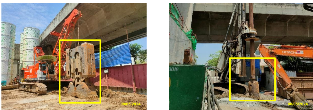
เสาเข็มเจาะหน้าตัดเหลี่ยม (Barrette Pile)
