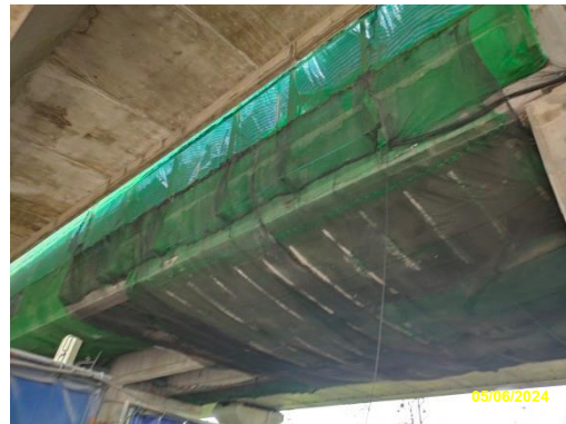
รูปที่ 2-10 การติดตั้งตาข่าย (Safety Net)
