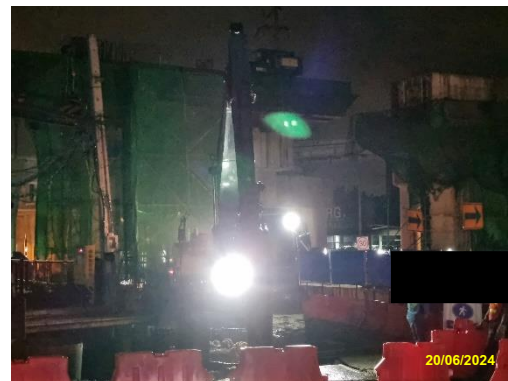
รูปที่ 2-51 การติดตั้งไฟส่องสว่างภายในพื้นที่ก่อสร้าง
