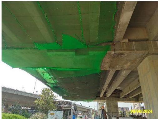
รูปที่ 2-10 การติดตั้งตาข่าย (Safety Net)
