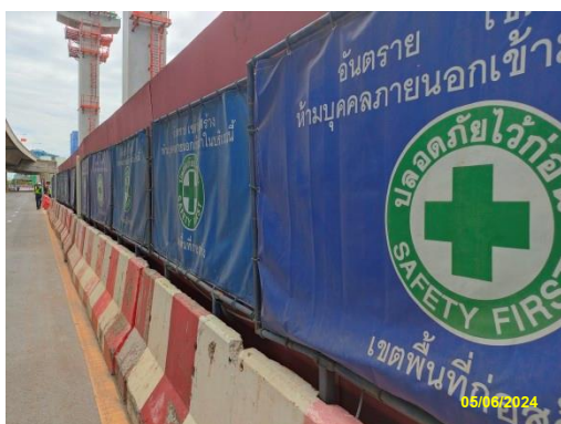
รูปที่ 2-17 การติดตั้งกำแพงคอนกรีต พร้อมรั้วผ้าใบทึบ ความสูง 2.0 เมตร
