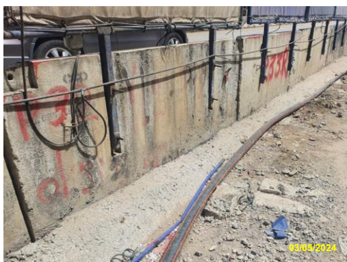
รูปที่ 2-12 การขยายขอบกำแพงกันพื้นที่ก่อสร้าง
