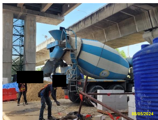
รูปที่ 2-18 การใช้คอนกรีตผสมเสร็จ
