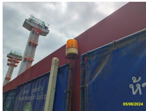
รูปที่ 2-36 การติดตั้งไฟกะพริบ
