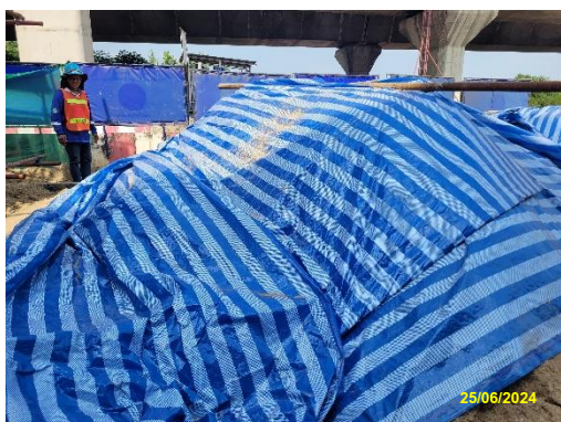
รูปที่ 2-25 การใช้ผ้าใบปิดคลุม กองดิน/กองเศษวัสดุ
